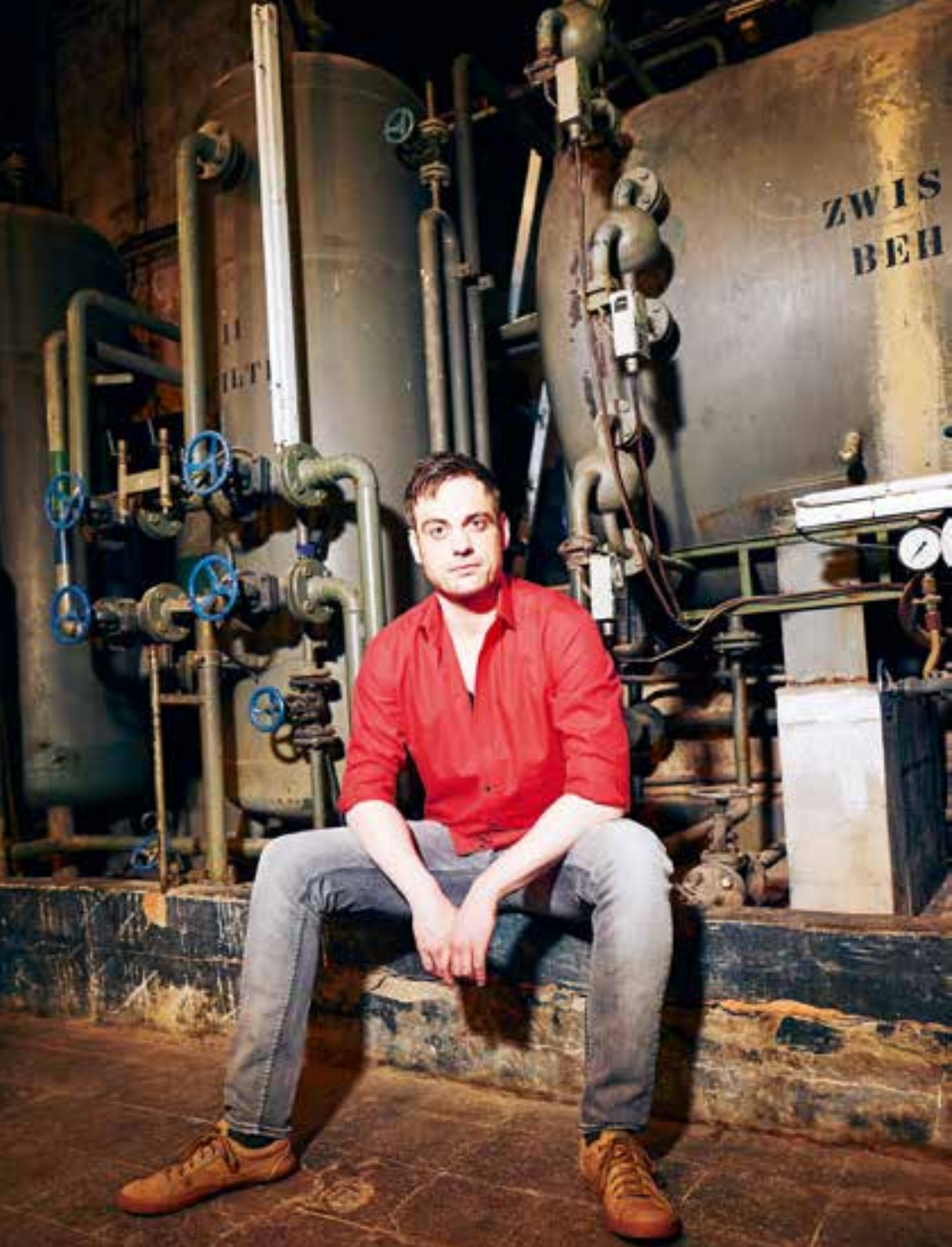
Bastian Heidenreich im Kesselsaal, E-Werk
